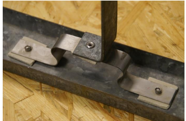
Unterkonstruktion mit Omegabügel zur Schallentkoppelung
