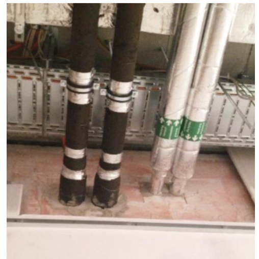
Vermörtelung von Brandwanddurchführungen Vorausgesetzt die Wandstärke ist mind. 100mm
