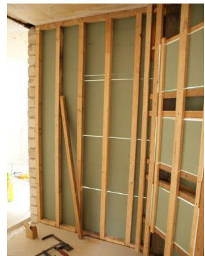
Ständerwerk beim Ausbau eines Dachgeschosses
