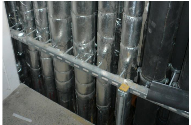
Offener Versorgungsschacht in einem Industriegebäude
