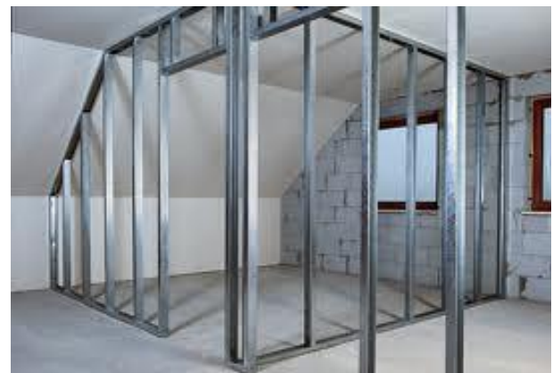
Ständerwerk beim Ausbau eines Dachgeschosses
