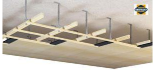
Holzunterkonstruktion befestigt mit Noniusabhängern
