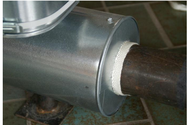
Stirnscheibe auf Glasgewebeband zur thermischen Trennung
