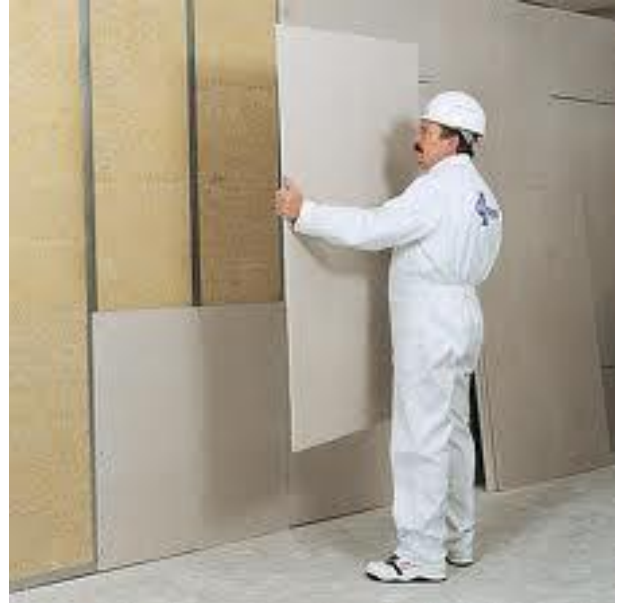
Beplankung einer Trennwand
