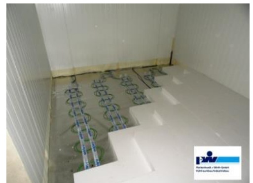
Einbau einer Unterfrierschutzheizung
