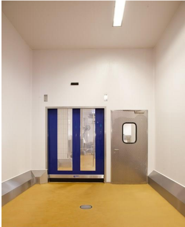
Abgerundete Sockelfliesen erleichtern Reinigungsarbeiten
