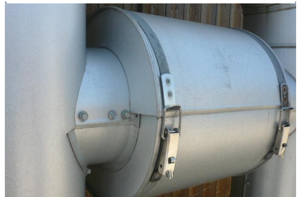
Flanschcappe im Außenbereich mit ferdergesichertem Kappenschloß und Schrauben mit Dichtscheiben
