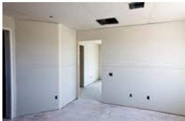
Trockenausbau in einem Bürogebäude
