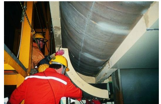
PU Formteile, trocken angesetzt, an den Kanten verklebt. Foto: Puren
