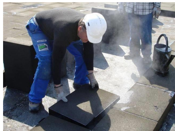
Schaumglasplatten in Heißbitumen
