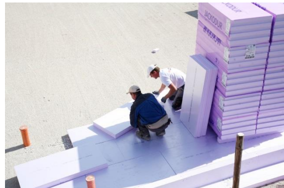
Verlegung von XPS Jackodurplatten©
