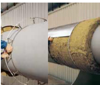
Anbringen der Abstandhalter bei Drahtnetzmatte erforderlich.
